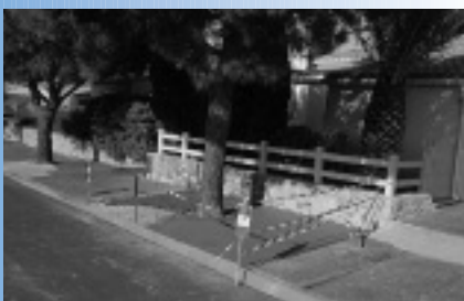
▲ Pech des Moulins : réfection des trottoirs résidence des Cabestans
