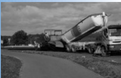
▲ Ayguades : nouvel enrobé avenue de la Felouque
